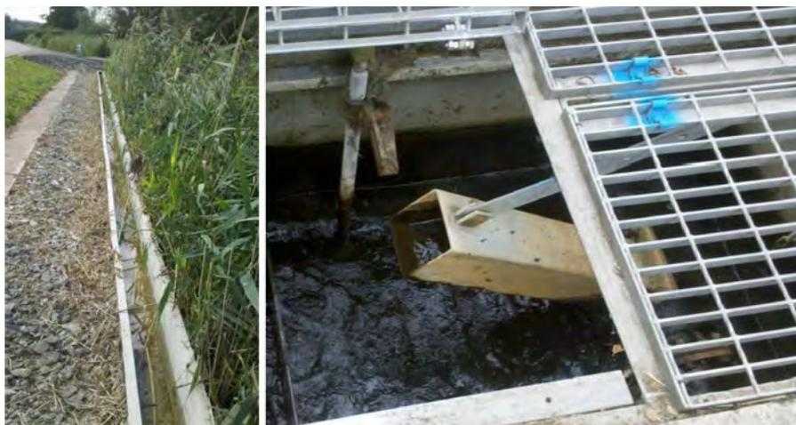
**Figure 3.2** Ejemplos de estructuras civiles en humedales de FH; Izquierda: canal de distribución; derecha: estructura de control de nivel de agua.
