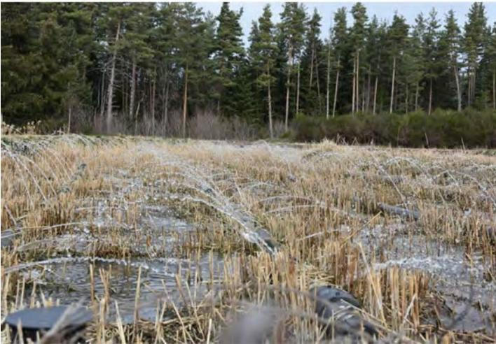
**Figure 5.4** Distribución de aguas residuales en un humedal de FV tipo francés; arriba: primera etapa; abajo: segunda etapa. Fotos cortesía de Pascal Molle.
