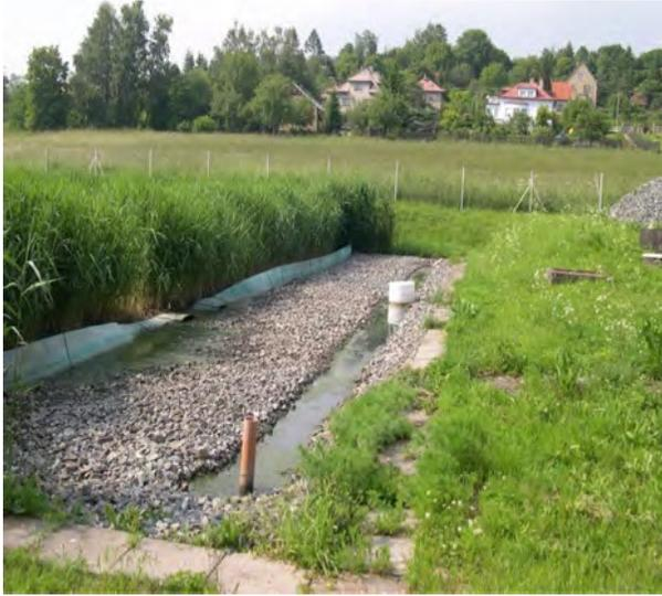
**Figure 3.6** Humedal de Ondřejov FH: lecho de FH con vegetación y distribución de la zona de entrada. Foto cortesía de Jan Vymazal.
