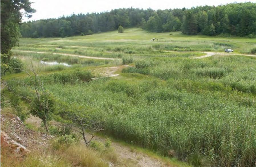
**Figure 7.3** Humedal Alhagen con los primeros humedales de entrada y los humedales alternativamente cargados oeste (izquierda), este (fondo) y el humedal de entrada (izquierda del automóvil) con un canal de derivación para aguas pluviales entre las vías. Foto cortesía de Christer Svedin.
