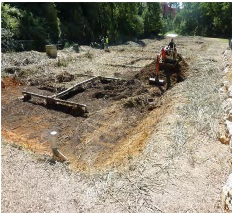
**Figura 5.8** Eliminación de lodos del humedal de FV tipo francés de primera etapa en Roussillon, Francia, después de 13 años de operación (Troesch y Esser, 2012)
