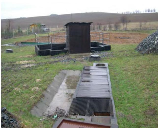
**Figure 3.5** Humedal Ondřejov FH: trampa de arena (frente), tanque Imhoff y cama vegetada de FH (atrás). Foto cortesía de Jan Vymazal.
