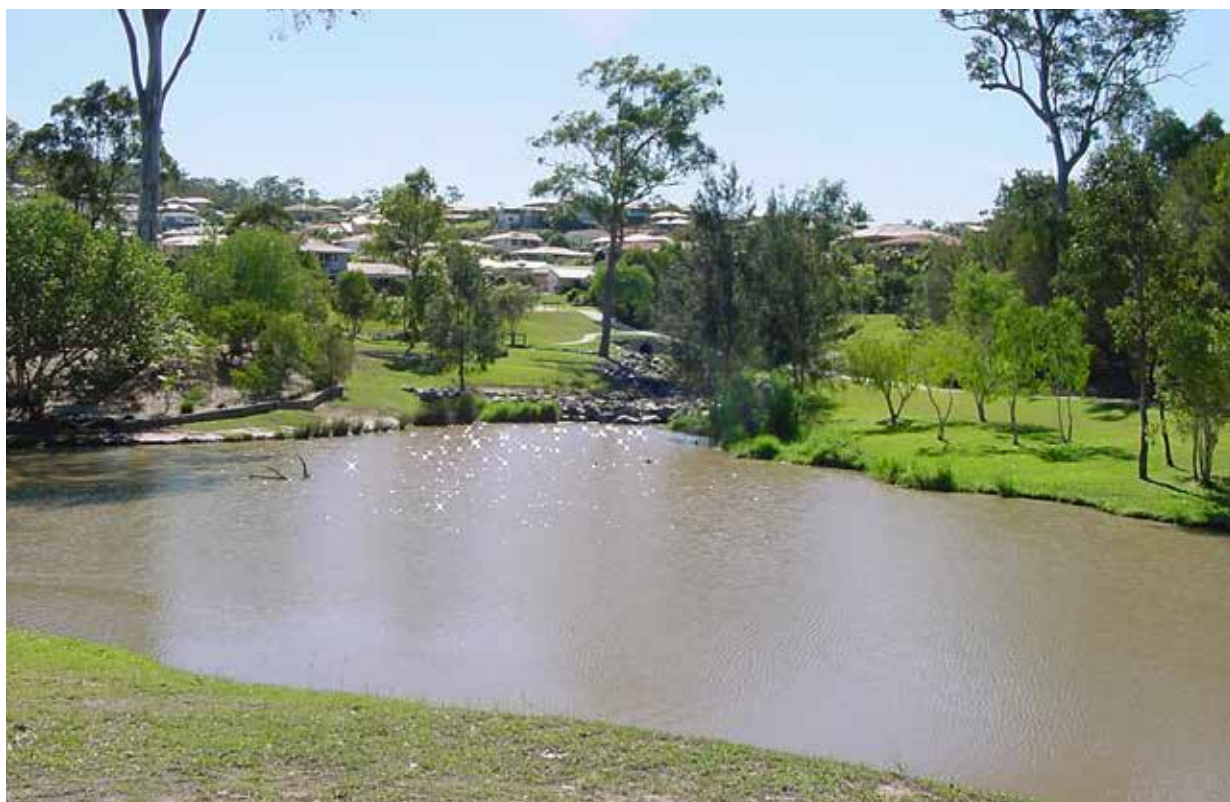
Bacia de retenção para águas de chuva, Gold Coast, Queensland, Austrália.
