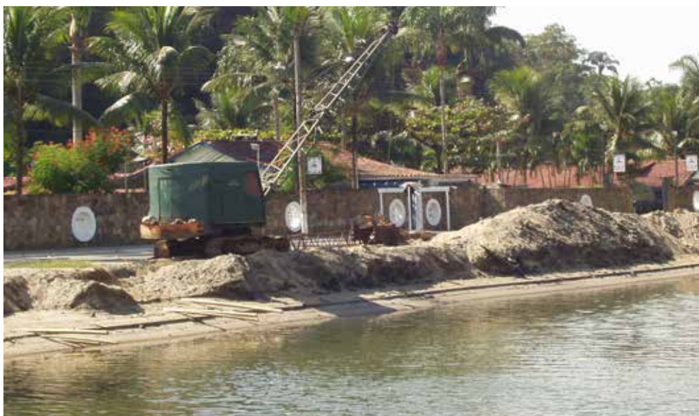
Dragagem das calhas do Rio Perequê-Açu, Paraty, RJ, Brasil.
