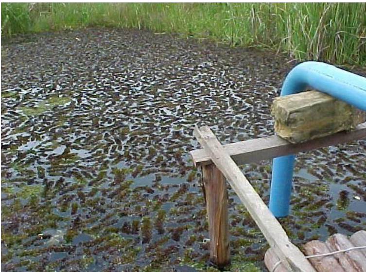
Figura 6 - Captação de água superficial em reservatório.
